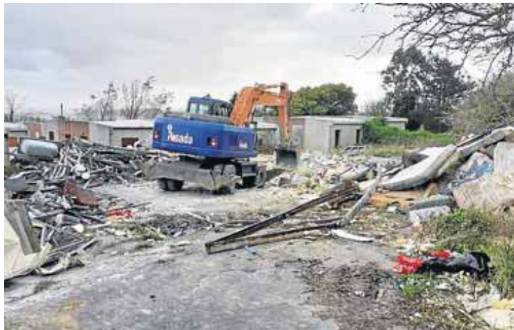
Una excavadora derriba las viviendas prefabricadas de Piñeres. A. c.
